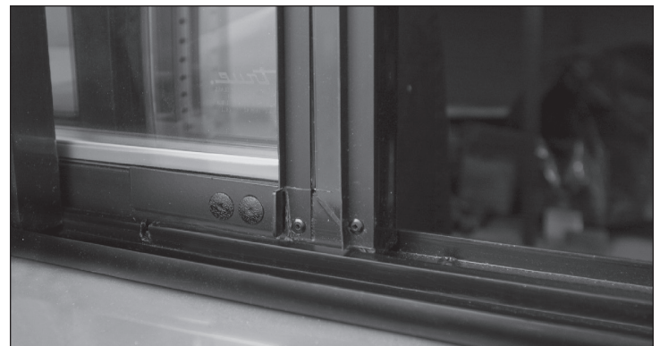
Abb. 2. Türverriegelung ist in der geschlossenen Position (aus Kerbe ausgerastet).
