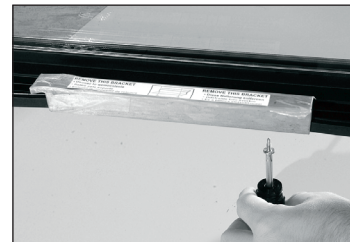
Afb. 2. Verwijder de transportbeugel van de glazen draaideur, indien aanwezig. Gooi deze niet weg.
