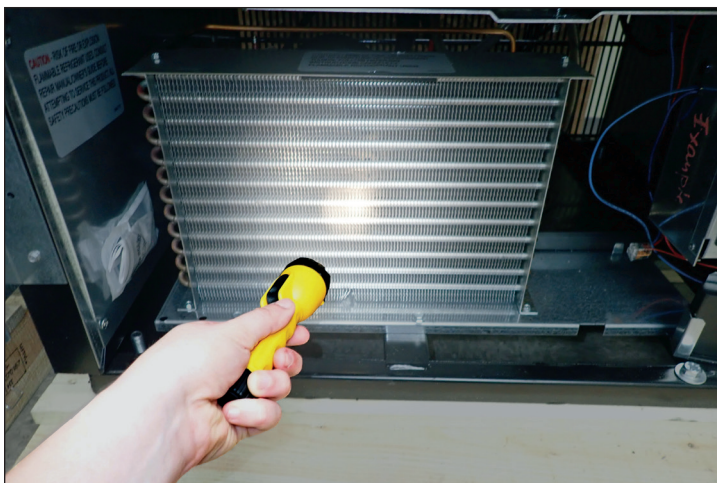
Fig. 3. Vérifiez que toutes les obstructions ont bien été éliminées.
