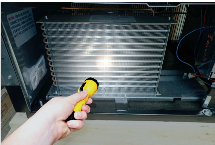
Abb. 3. Prüfen, ob alle Verstopfungen beseitigt wurden.
