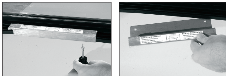
Рис. 2. Удалите транспортировочный кронштейн стеклянной распашной двери при его наличии. Не выбрасывайте его.
