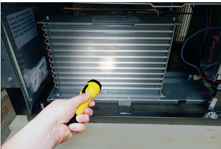
Fig. 3. Compruebe que se hayan eliminado todas las obstrucciones.
