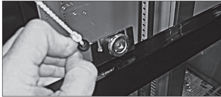
الشكل 8. حرّك اللسان الأسود الذي يحمل سلك الباب للخارج من الجانب الخلفي لحامل البكرة.
