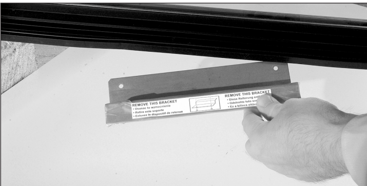
الشكل 2. انزع حامل نقل الباب الزجاجي المتأرجح، إذا كان ذلك مرفقًا. ولا تتخلص منه.
