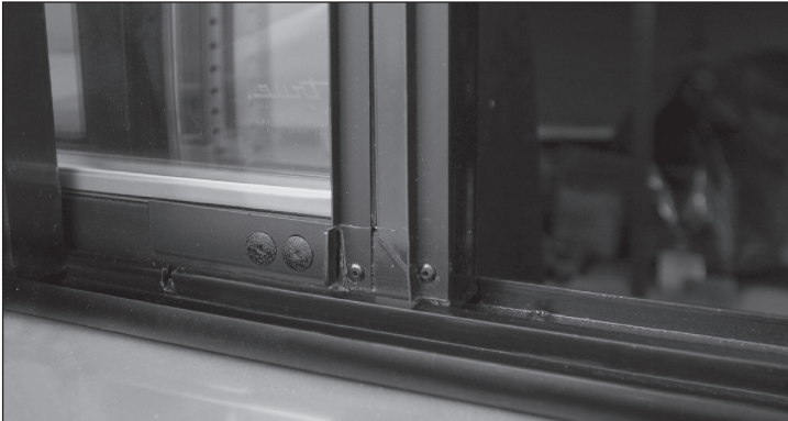
الشكل 2. مزلاج الباب في الوضع المغلق (مفصول عن الندبة).
