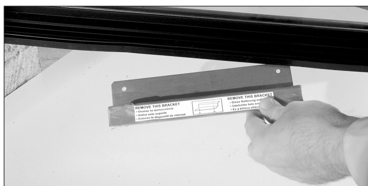
Fig. 2. Remova o suporte de transporte das portas pivotantes de vidro, se estiver instalado. Não descarte.
