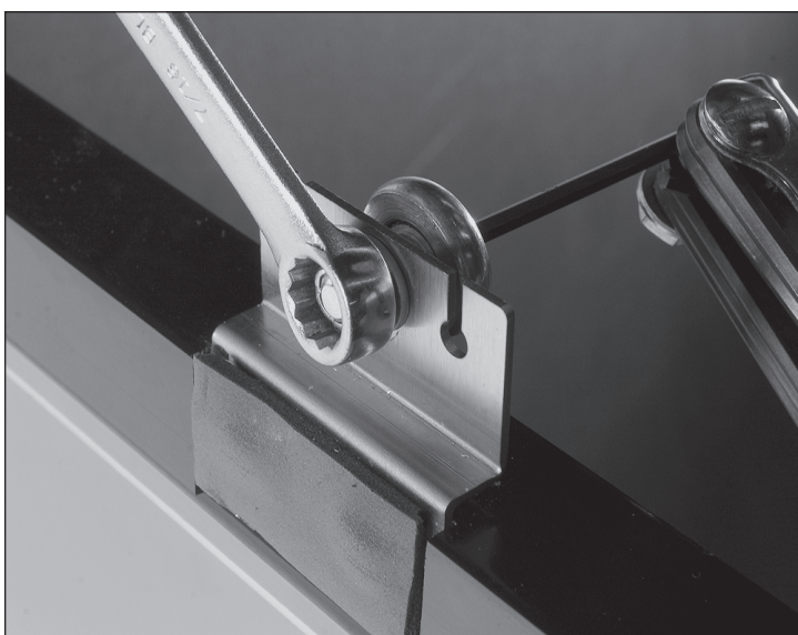
Рис. 1. Отрегулировать ролик.
