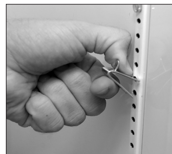
Рис. 2. Нижняя часть кронштейна должна зафиксироваться.
