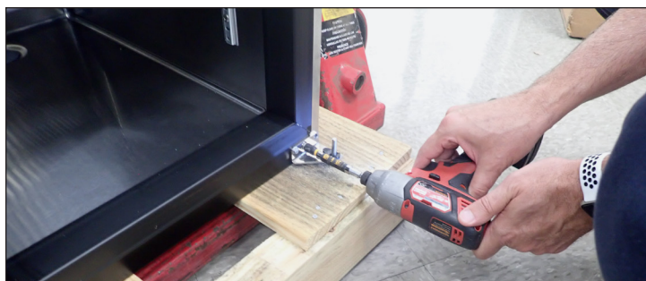
Рис. 7. Смонтируйте нижнюю петлю на противоположной стороне проема двери.
