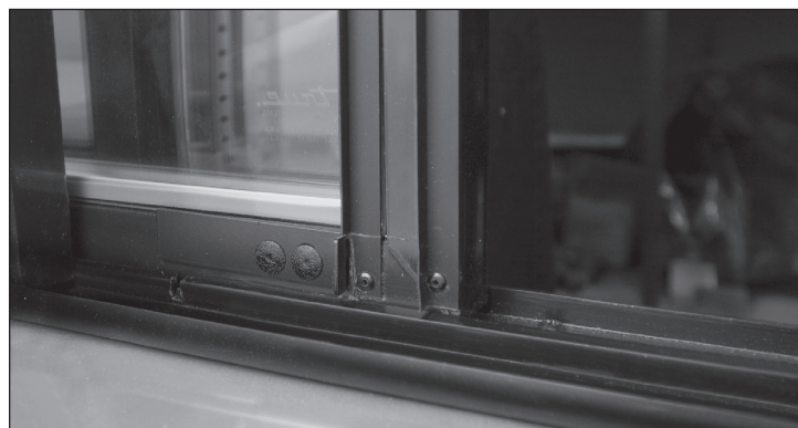
Рис. 2. Дверная задвижка в закрытом положении (выведена из выемки).
